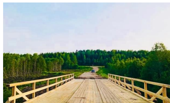
Мост на подъезде к поселку Пяжелка
