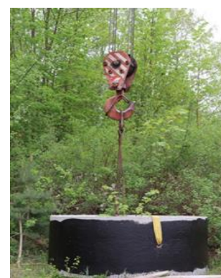
Дюкер напорного коллектора
