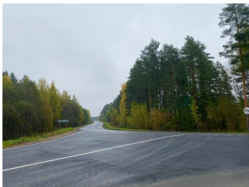
Ремонт участка дороги Бабаево - Торопово
